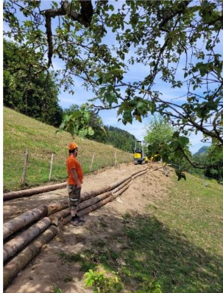
In den zwei Einsatzwochen wurden auf dieser Baustelle rund 30-40 m<sup>3</sup> Kies verbaut, dazu Baumstämme zugeschnitten und mit Armierungseisen gesichert.
