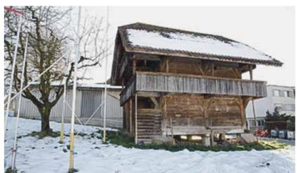
Abb. 2. Der Kornspeicher (Baujahr 1769) zum Aebesoldhaus wurde 1966 an diese Stelle versetzt. Die drei Lagerböden sind ostseitig über Treppen erreich-Bild: Archäologischer Dienst, Benedikt Gfeller. bar. Blick nach Süden.
