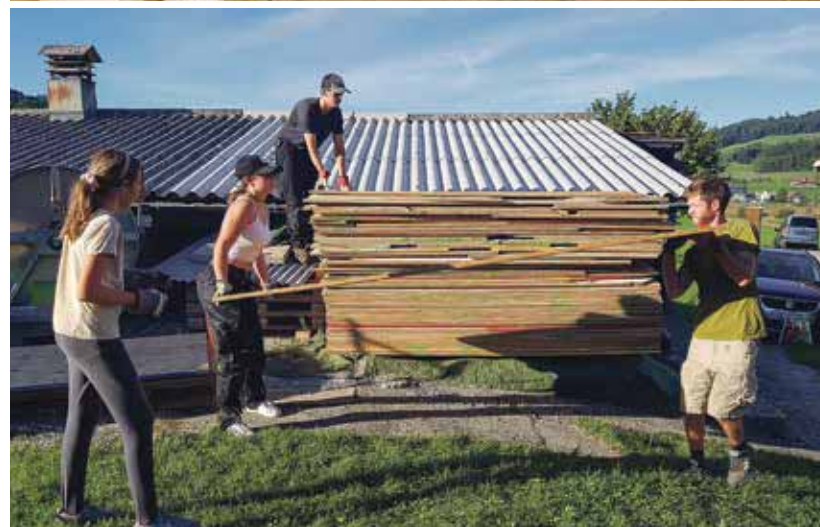
Freiwillige helfen beim Bau des Boulderparks Worb.
