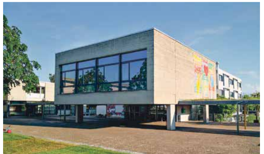
Trakt 3 der Schulanlage Rüfenacht.
