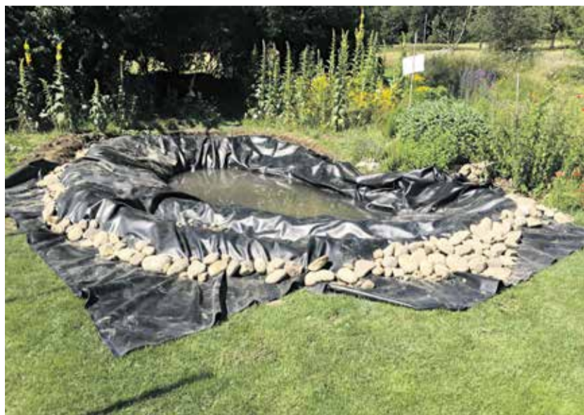
Der Teich in Vielbringen in der Bauphase.
