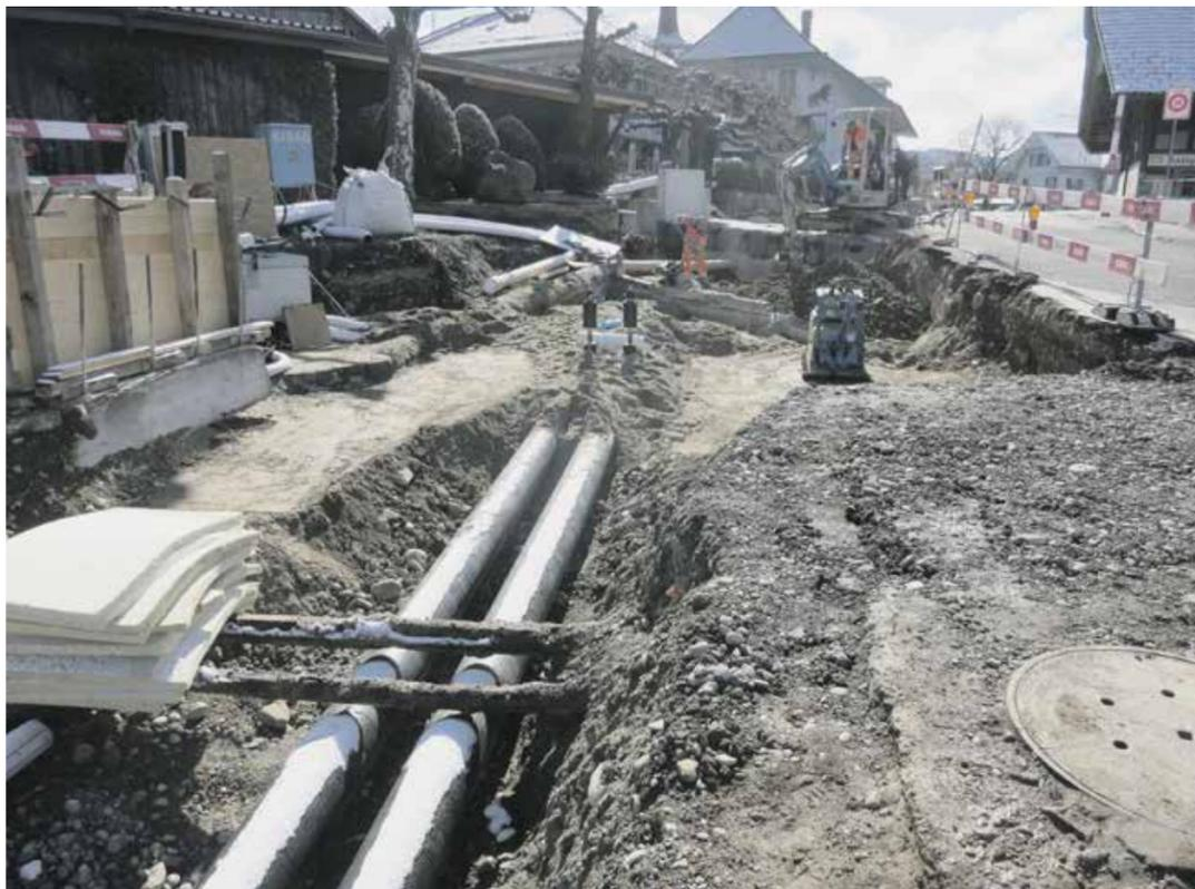
Die Bollstrasse wird abschnittsweise saniert: Zuerst der Graben für die Werkleitungen, dann folgt der Strassenbau. Bild: zvg
