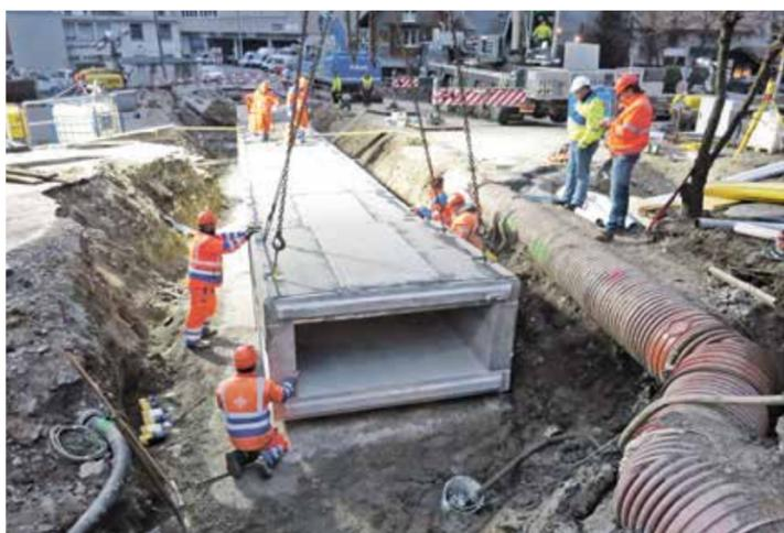
Betonelemente des neuen, leicht vergrösserten Durchlasses für den Enggistebach, die Ende Februar während der Intensivbauphase in die Bollstrasse gehievt wurden. Bild: zvg
