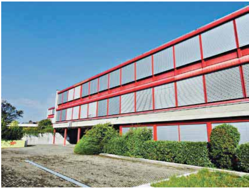
Die Gebäudehülle des Oberstufenzentrums Worboden muss saniert werden. Bild: M. Zurflüh
