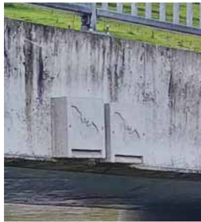
Diskret an Brücken montiert: Kästen aus Faserzement sollen Fledermäusen als Unterschlupf dienen. Bilder: I. Krämer
