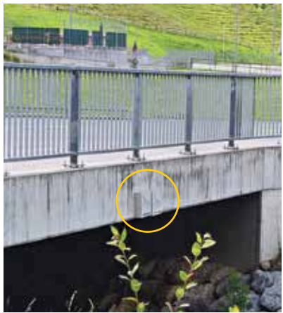
Diskret an Brücken montiert: Kästen aus Faserzement sollen Fledermäusen als Unterschlupf dienen. Bilder: I. Krämer
