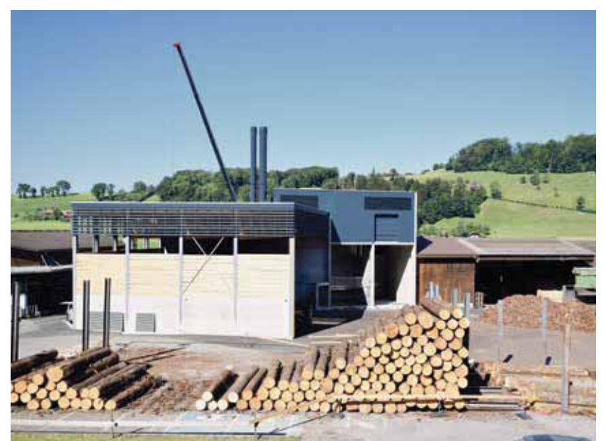
Die neue Fernwärme-Zentrale auf dem OLWO-Areal.
