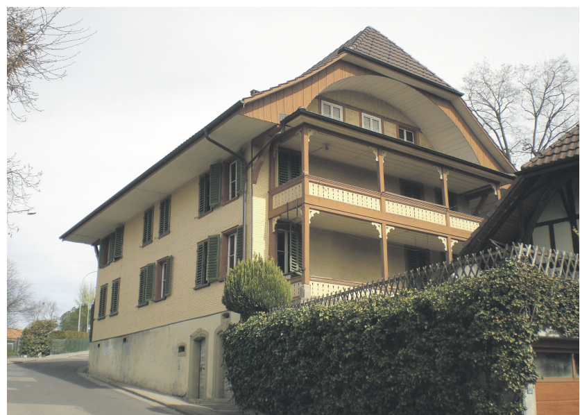
Das 1812 erbaute Worber Primarschulhaus an der Eggasse. Fotos MC
