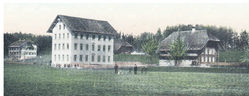
Neues und altes Schulhaus zwischen Vielbringen und Rüfenacht um 1900. Fotos IG Worber Geschichte und MC
