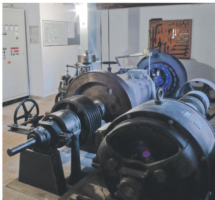
Mit dem Wasser des Enggsteinbachs produziert das heutige Kleinwasserkraftwerk der Alten Mühle Worber Strom für 35 Vier-Personenhaushalte (durchschnittl. 139000 kWh/a). Quelle: PA
