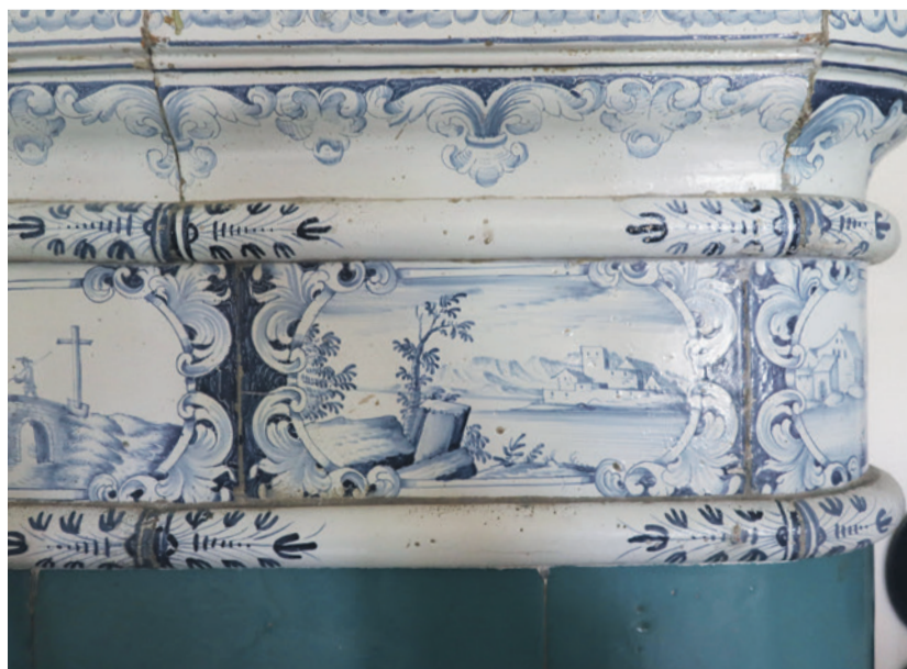
Grosszügig gemalte barocke Fries- und Gesimskacheln und meergrüne Blattkacheln des aus der Bauzeit des Hauses um 1730 stammenden Ofens. Bild: zvg
