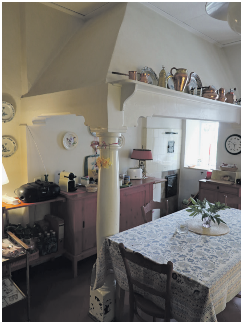
Das aus der Bauzeit um 1730 errichtete Küchenkamin, das heute noch zum Beheizen des Kachelofens im kleinen Salon dient. Bild: zvg
