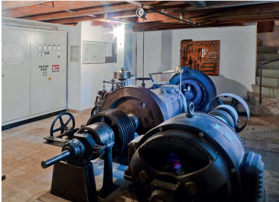
Kleinwasserkraftwerk – Maschinengruppe von 1945 mit revidierter Turbine und neuem Generator
