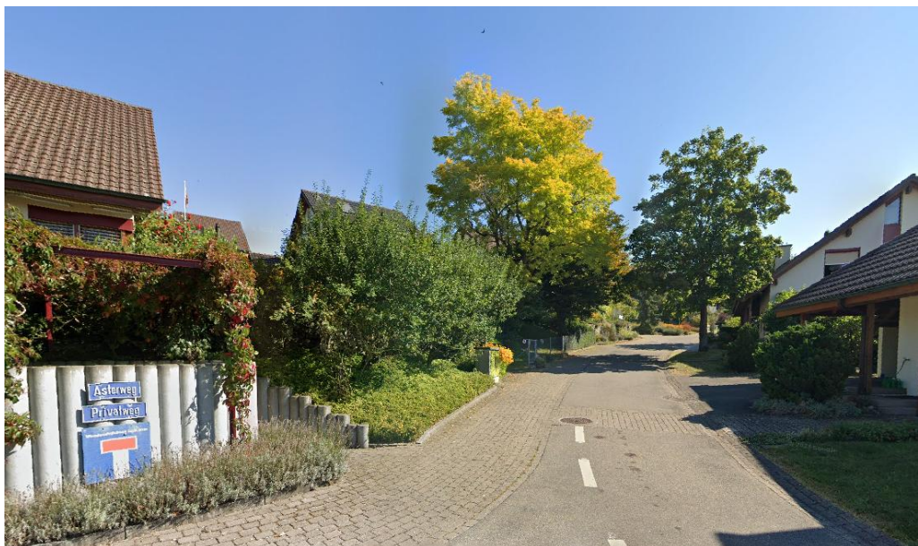
Abb. 4: Pflasterung als Gestaltungsmaßnahme im Asterweg
